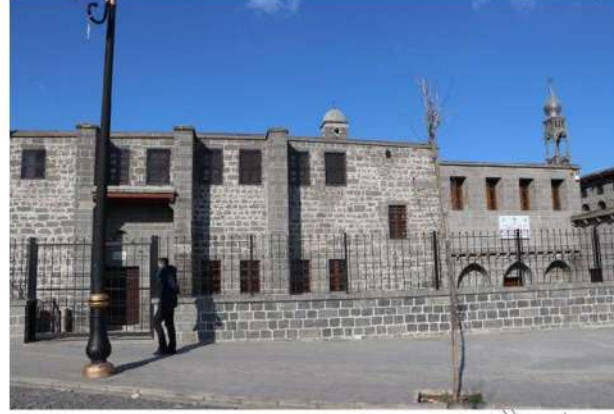
foto: https://www.sakinca.com/ / Uygulama sonrası
